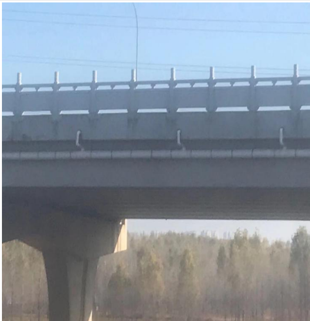
南岸桥面雨污排水系统
