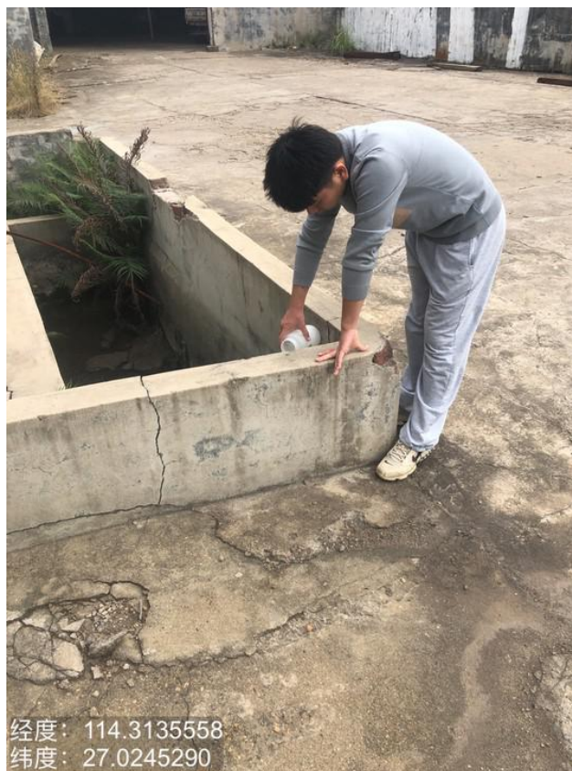
生活污水出口
