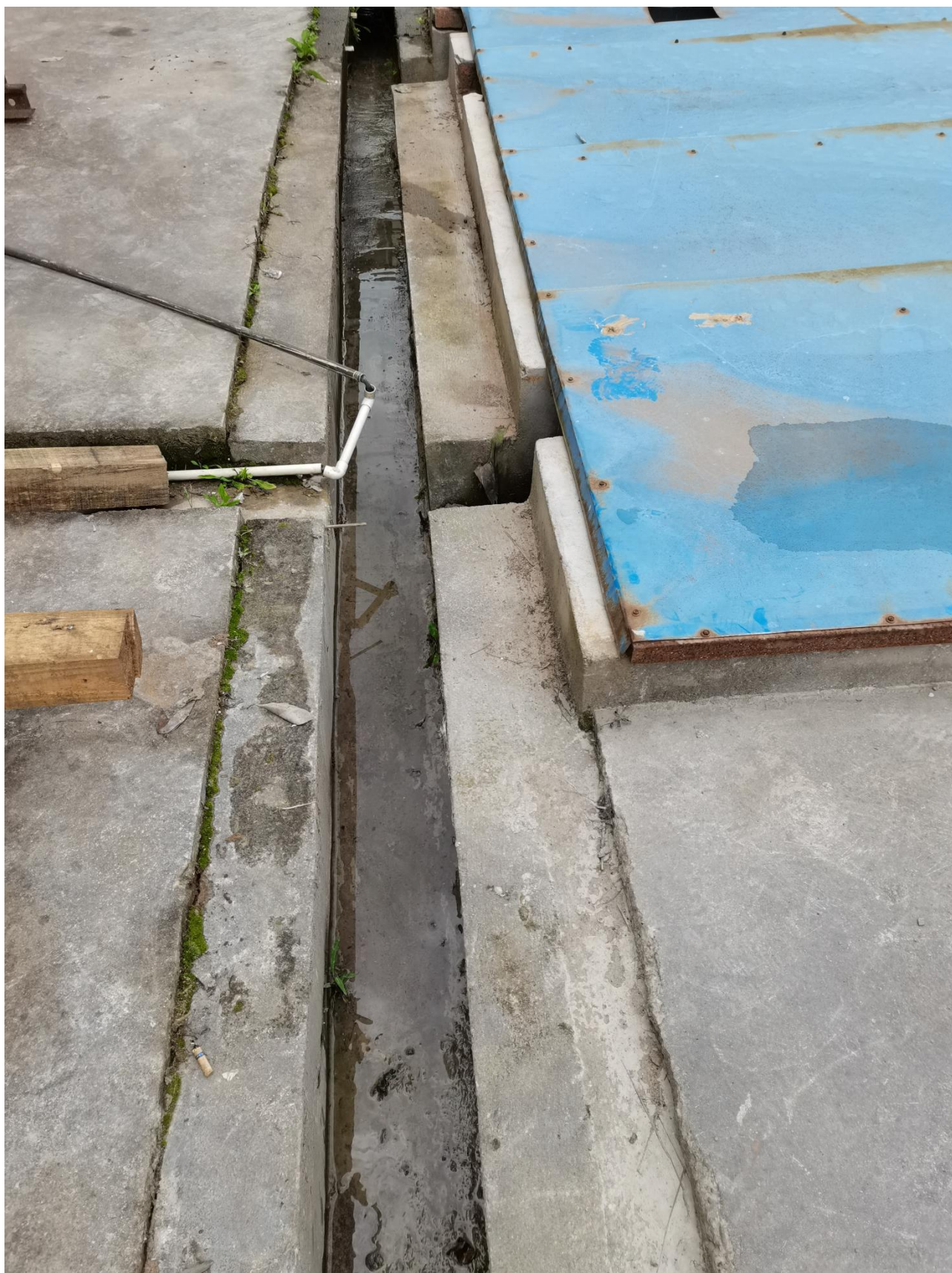
附件10 排水沟照片
