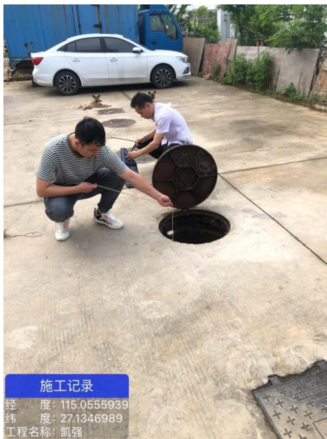
综合废水排放口
