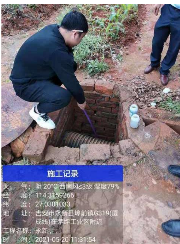
生活污水出口
