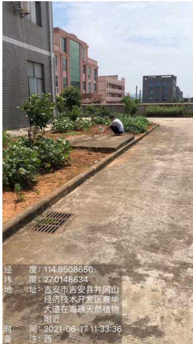
综合废水排放口
