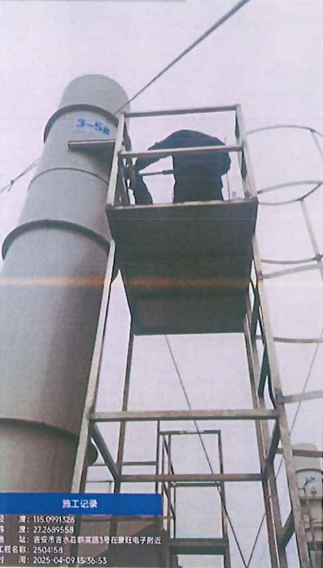
1.2期3号厂房3-5#出口
