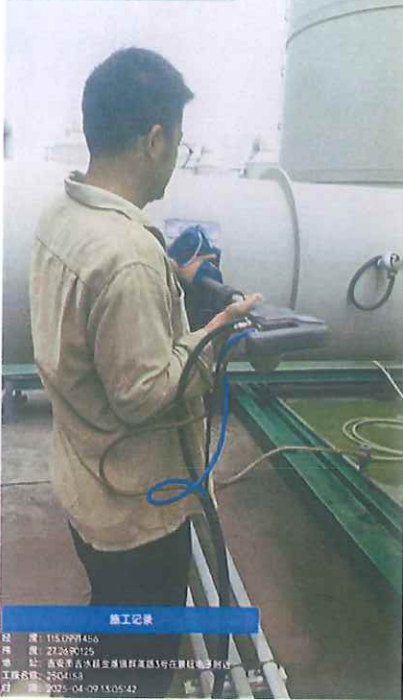
1.2期3号厂房3-4#进口
